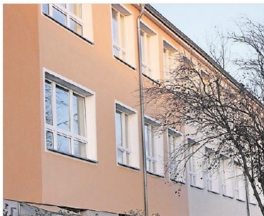
Im Schulgebäude sollen im Dezember Umbauarbeiten für die neue Grundschule beginnen.
